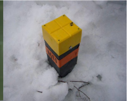
図-3 杭設置状況
