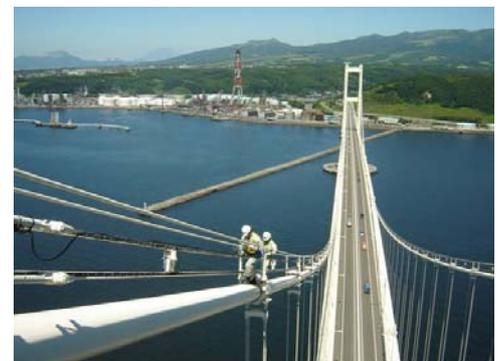
写真-2 吊り橋での点検作業
