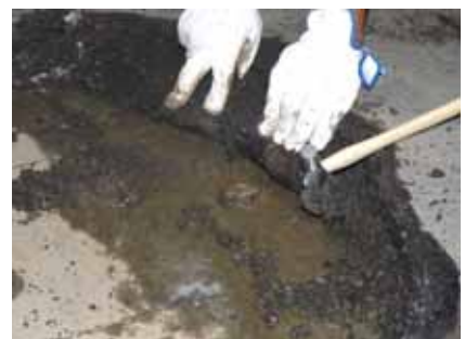
写真3：舗装を撤去した状態
