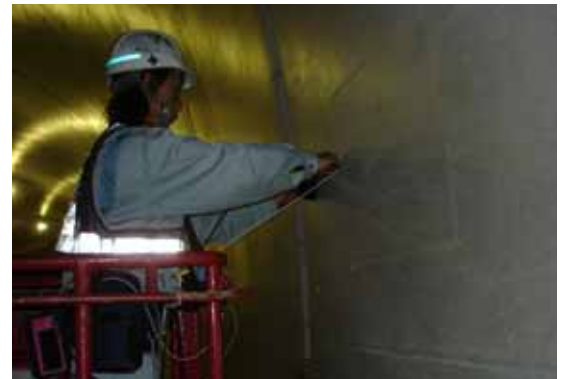
写真-3 調査状況
