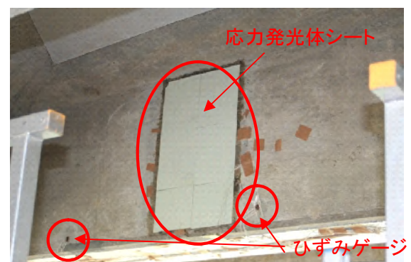
図-2 応力発光体シート貼付状況
