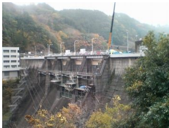
写真-2 重力式コンクリートダム（下流側）
