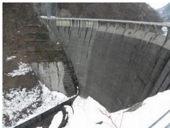
写真-1 アーチ式コンクリートダム（下流側）
