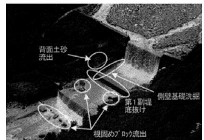
図3 平成17年6月出水による主な被災状況<sup>3)</sup>
