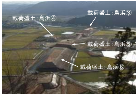
写真-4 鳥浜地区の载荷盛土
