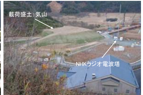
写真-5 気山地区の载荷盛土
