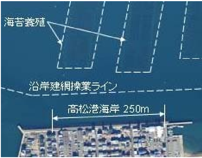
高松港海岸現場状況
