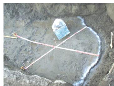
網掛部は採用ケース 写真-1 改良径確認状況
