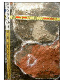
図-5 改良体出来形
