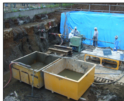
図-3 試験施工状況
