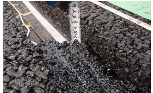
写真-2 グースアスファルトの充填状況
