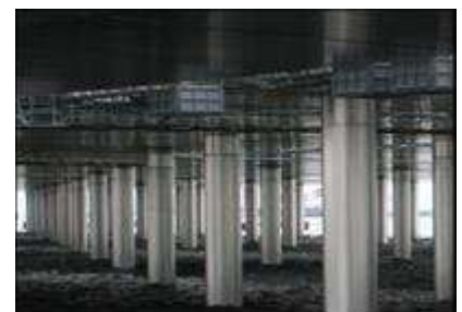
図-4 ジャケット式栈橋レグ部
