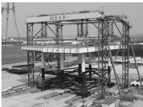
写真-2 上部工吊上げ装置 (富津工場)
