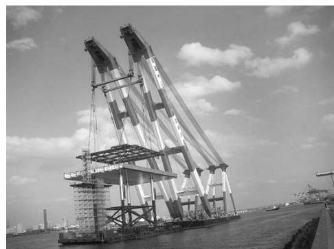
写真-3 完成ジャケットの積込と固縛方法
