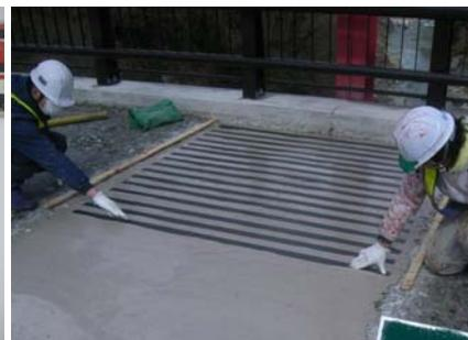
写真-4 CFRP 成型板設置中
