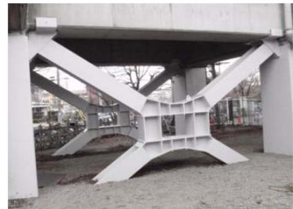
写真-1 ダンパー・ブレースの適用状況(R9)
