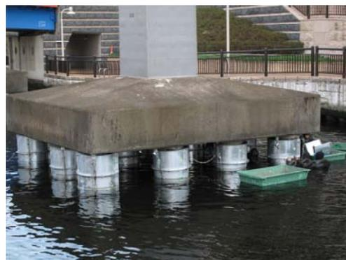
写真-1 補強鋼板を設置した状況
