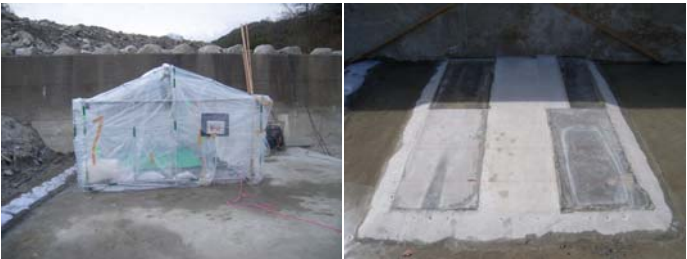
写真-1 養生状況
