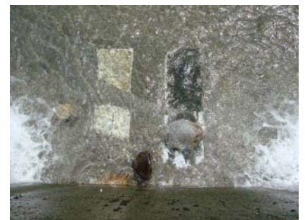
写真-3 74 日経過後の状況
