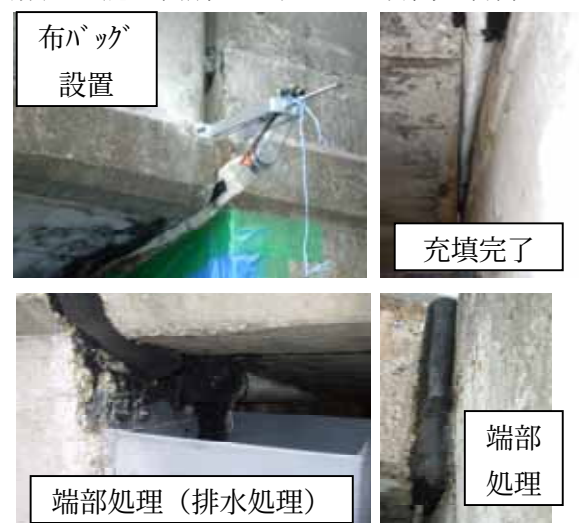
写真-1 施工状況
