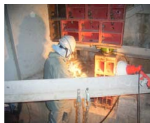
写真-5. 施工状況
