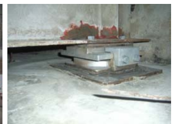
写真-6. 交換後の沓座
