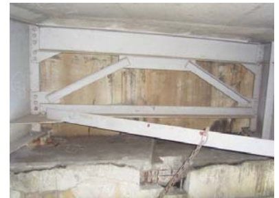
写真-2. 施工現場状況
