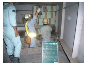
写真-4. 現場検討状況
