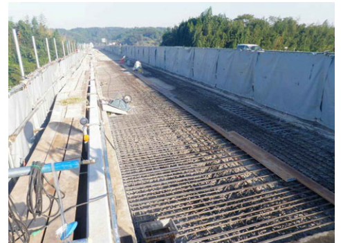
写真-2 はつり後のコンクリート撤去状況
