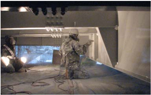
写真-1 スプレー吹付状況
