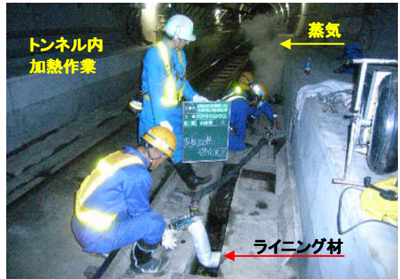
写真-3 加熱作業状況
