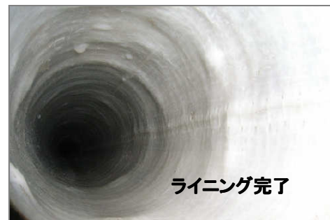
写真-4 管内ライニング完了状況
