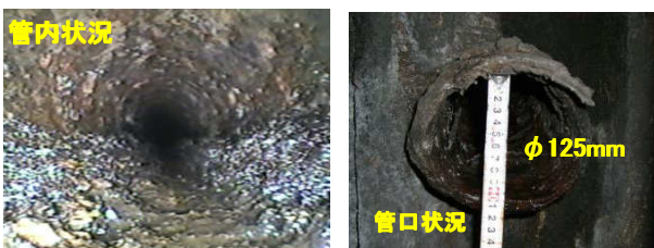
写真-1 既設管状況写真
