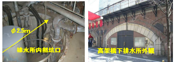
写真-2 排水所立坑坑口・外観状況写真
