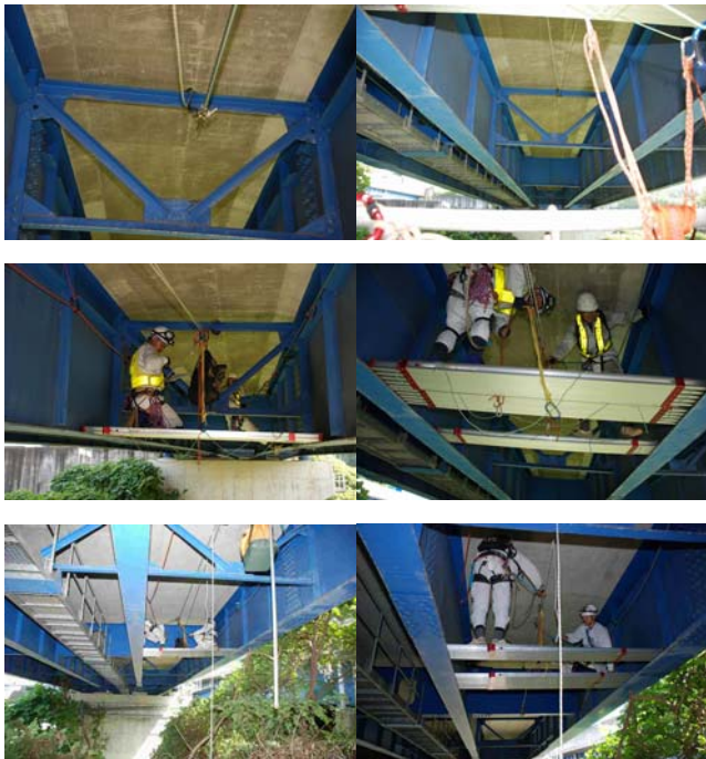
写真-2 メインロープの架設と点検員の移動
