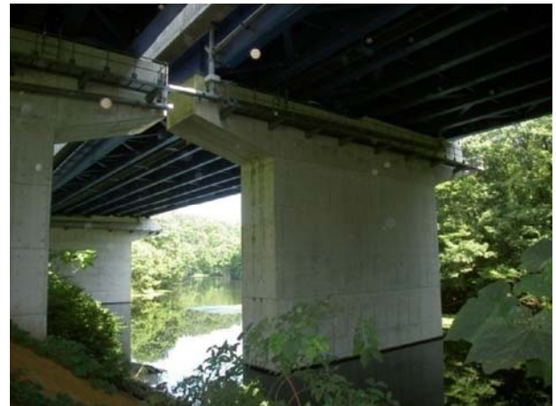
写真-1 桁下状況写真
