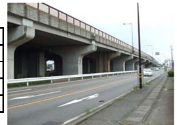
写真-1 A橋側面
