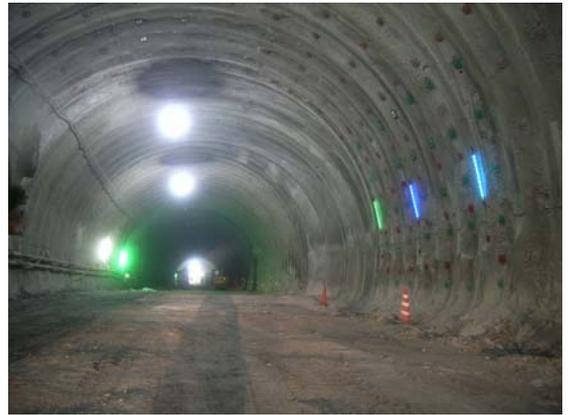
写真-4 光る変位計設置状況（縫い返し部）
