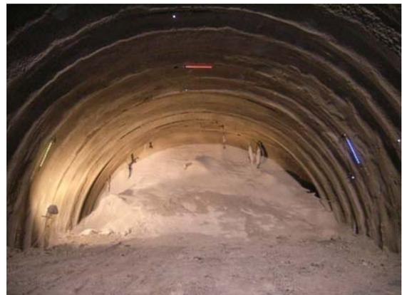
写真-2 光る変位計設置状況 (切羽部)
