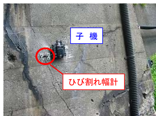
図-3 ひび割れ幅計および子機設置状況
