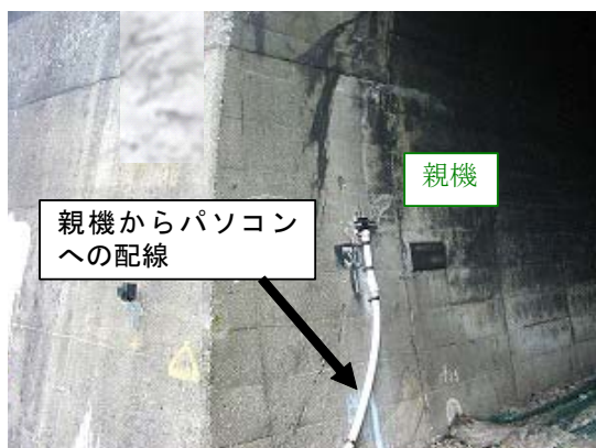
図-2 親機設置状況
