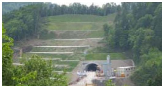
写真-1 東側坑口部の地すべり対策押え盛土工
