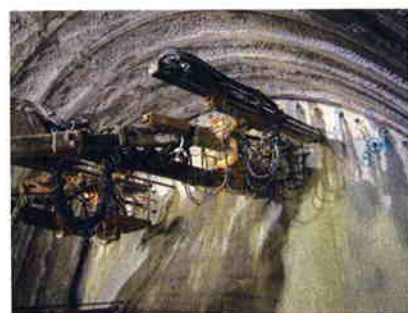
写真-2 長尺鋼管鏡ボルト施工状況
