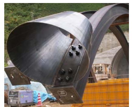
写真—1 YM コーン取付状況
