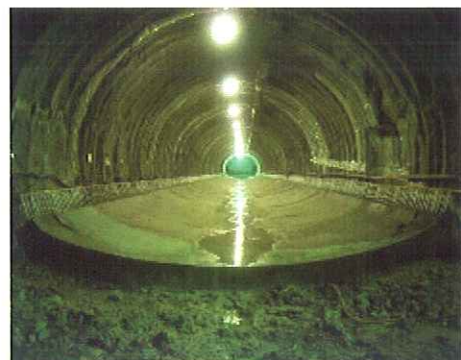
図3 インバートコンクリート全景
