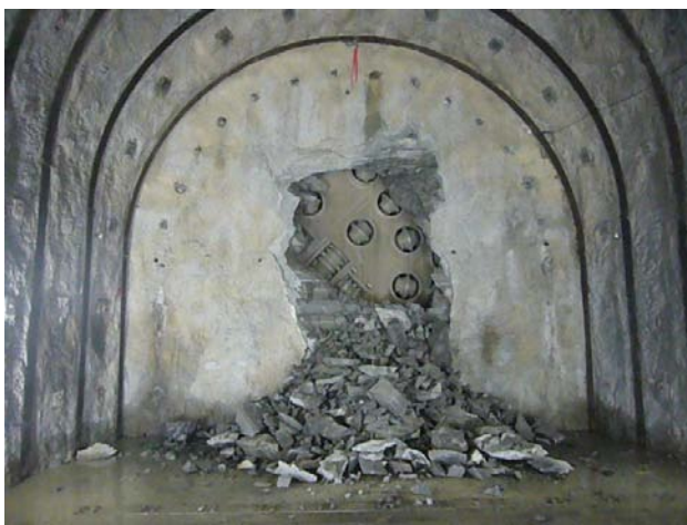
写真-1 TBMの到達
