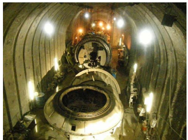
写真-2 TBM解体状況
