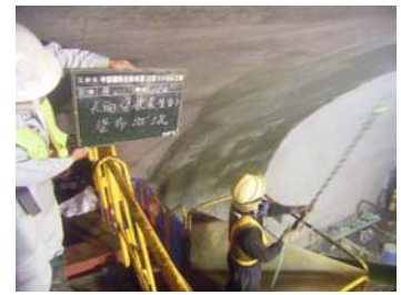
写真-2 脱型後 表面養生剤塗布状況
