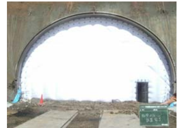
写真-3 隔壁バルーン
