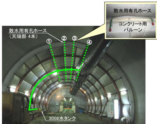
写真-1 散水機能付きコンクリート用バルーン全景
