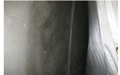
写真-4 散水1日後の覆工表面
