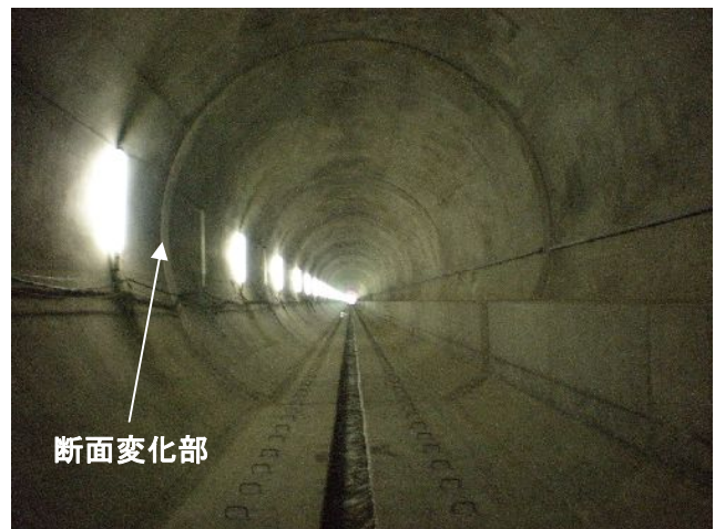
写真-2 アーチコンクリート全景
