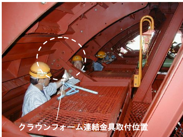
写真-3 連結金具盛替状況その1
