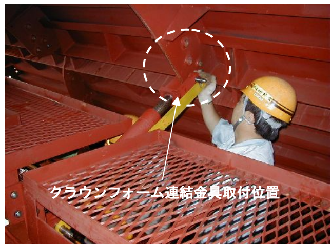
写真-4 連結金具盛替状況その2
