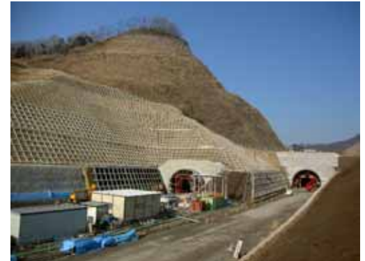
写真-1 現場状況（2010.2）
