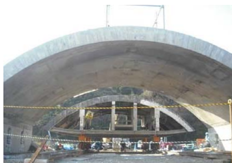
内空側仕上がり
