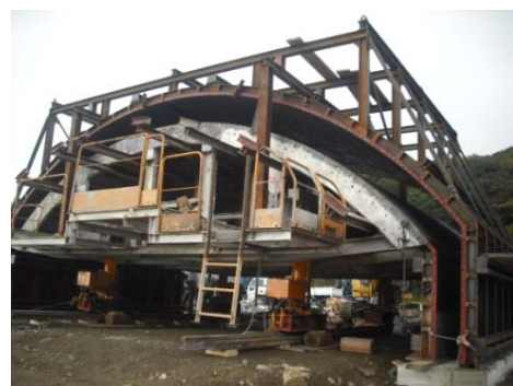
写真-1 使用した実物大型枠 (セントルのクラウン部を利用)
