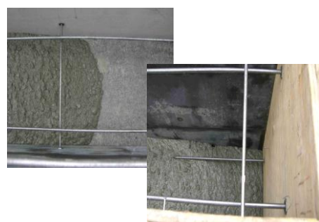
写真-2 増粘剤系配合の流動先端状況
