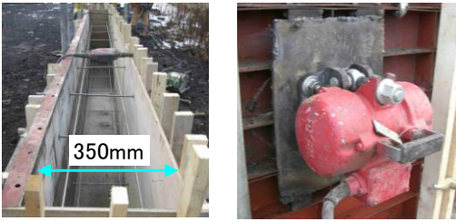
写真-1 模擬型枠および型枠パイプの概要
