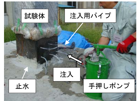
写真1 補修材の注入状況
