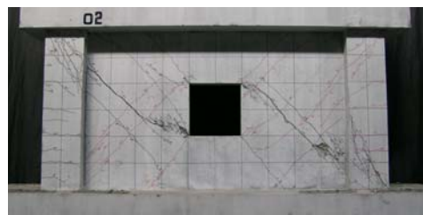
図-2 実験の破壊状況 (Push-over時)
