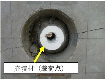
図-6 くさび削孔試験体の載荷面
