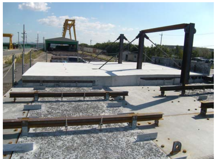
写真-1 実物大試験体（床版施工後）
