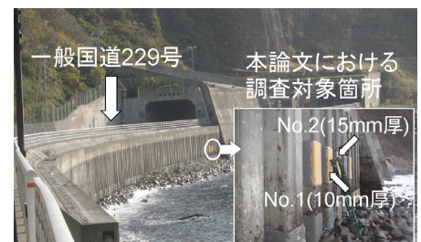
写真-1 スリット擁壁脚柱の全景 (調査は 2009 年 10 月に実施)
