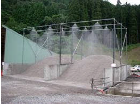
写真3 再生骨材散水設備
