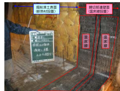
写真-1 断熱材・温床線設置状況
