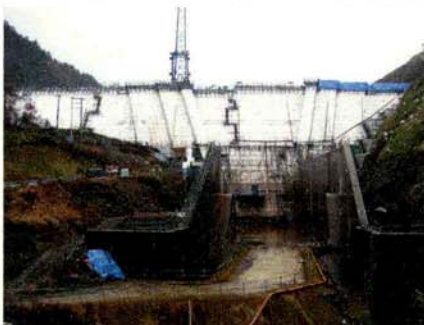
写真-1 堤体下流面養生状況全景
