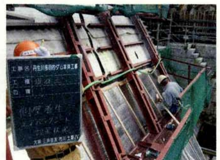
写真-3 断熱シート貼付状況
