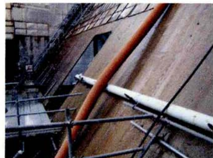
写真-5 シート撤去後の堤体下流面(接写)
