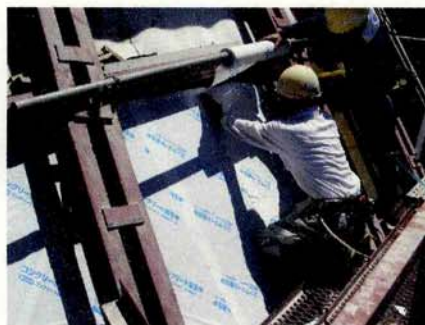
写真-2 保水テープ貼付状況
