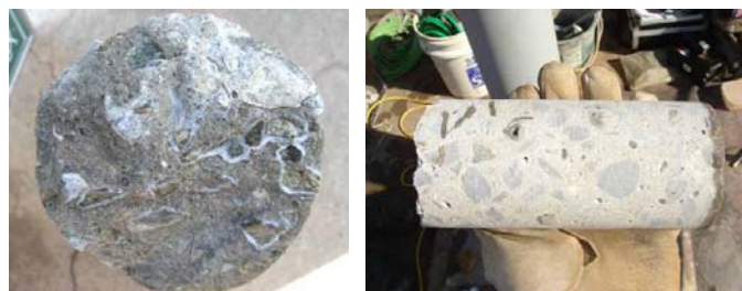
(a)試料の断面状況 (b)試料の側面状況
