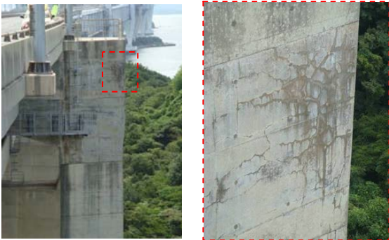
写真-1 外観状況
