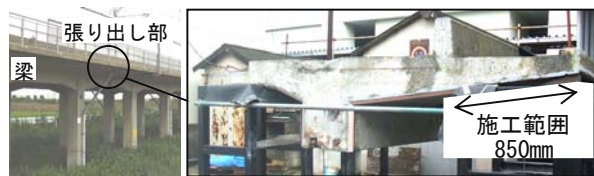
写真-1 施工試験の対象
