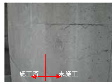
図-6 施工境界付近の状況
