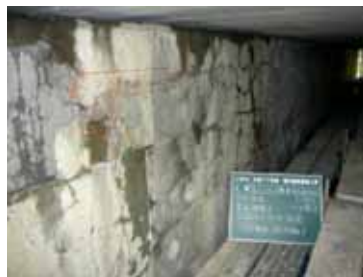
図-3 施工前の外観状況
