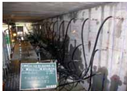
図-1 陶橋 施工状況
