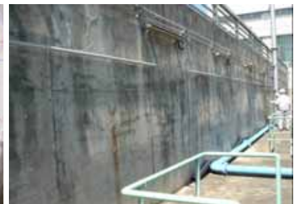
図-2 施設内擁壁 施工前外観
