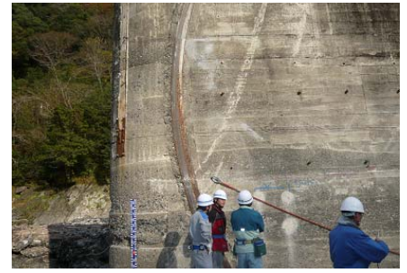
図-4 H鋼埋設部試験状況
